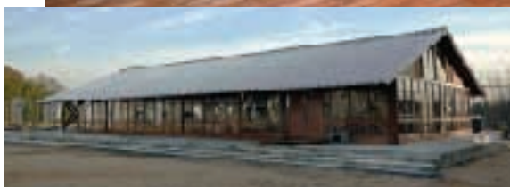
苦勞した屋根も立派です
