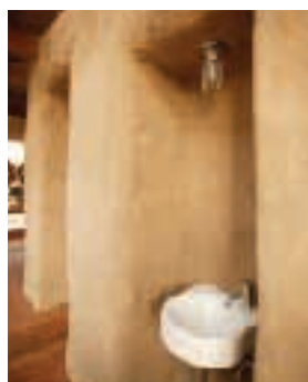
ストローペイルのトイレ
