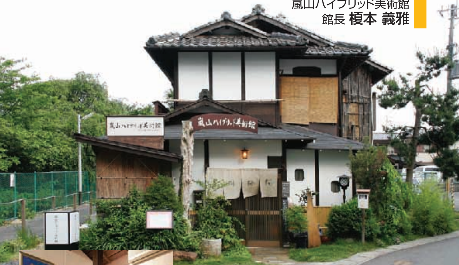
嵐山駅の隣に立地。廃屋同然だったなんて信じられない。
