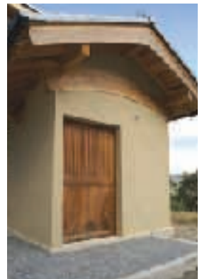
玄関外観／妻壁に見える小屋梁。山で始めてみた杉の曲がり材である。
