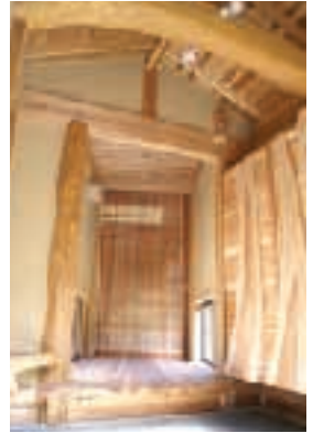
玄関／左の柱は天然しぼり丸太。上に見えるのは天然スキの小屋梁。下駄箱の建具は玄関妻壁に見える小屋梁のコアをとっておいだものを建具職人のアイデアでできたもの。
