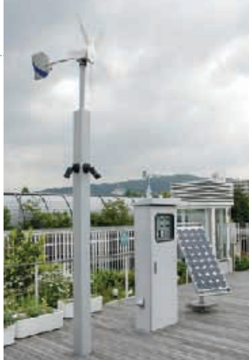
風力発電(左)と太陽光発電(右)の蓄電器。発電量もわかる
