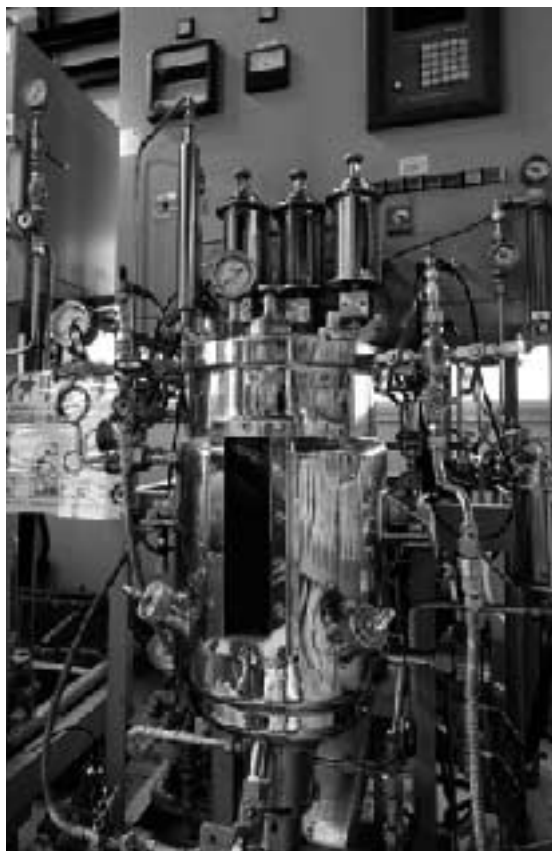
北九州エコタウンにあるケミカルリサイクル実証設備
