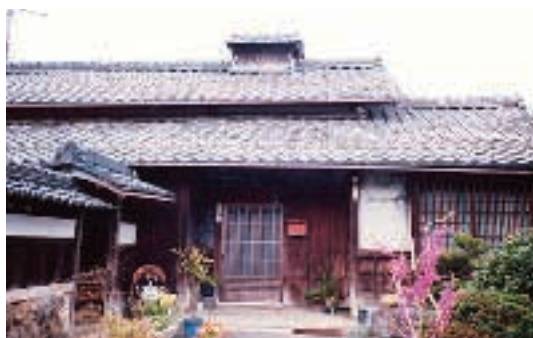
改装前の古民家
