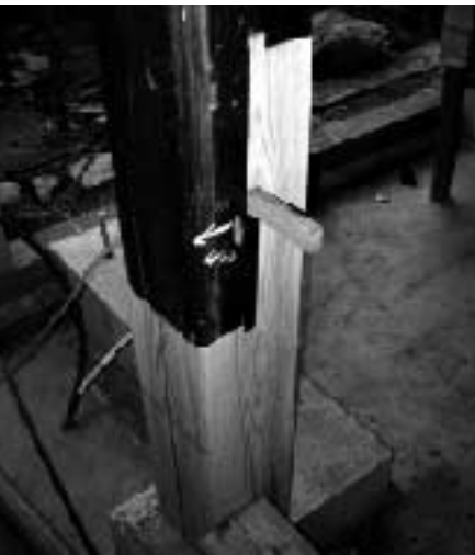
傷んだ柱の根元を差し替え(根継ぎ)
