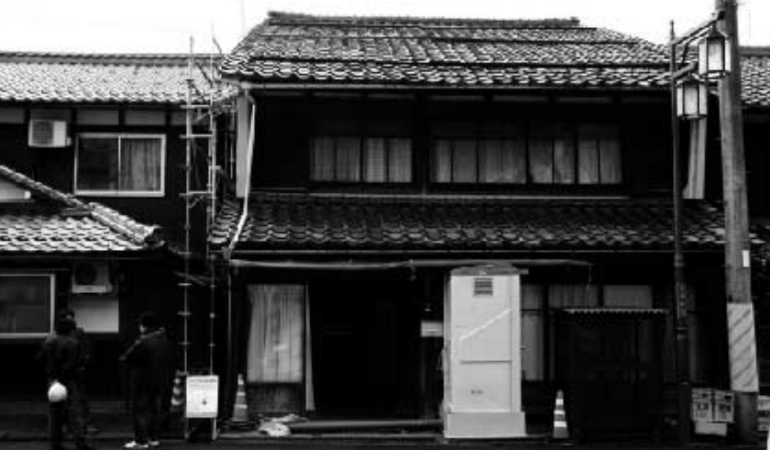
町家再生の舞台となった町家
