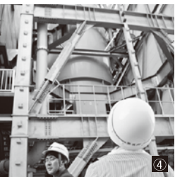
①佐和山・大洞弁財天も近い。サンショウウオがいるとか ②微粒子を取り除く急速ろ過池 ③濃縮汚泥を押し込んで水分を取り除く汚泥脱水機 ④汚泥ケーキを一時貯留するケーキ貯留層
