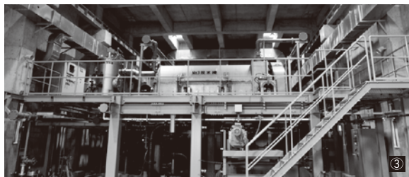
①佐和山・大洞弁財天も近い。サンショウウオがいるとか ②微粒子を取り除く急速ろ過池 ③濃縮汚泥を押し込んで水分を取り除く汚泥脱水機 ④汚泥ケーキを一時貯留するケーキ貯留層
