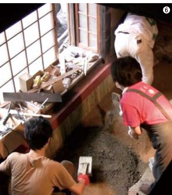
①改修前の古民家 ②紅殻を塗る ③天井からの風景 ④竹小舞をあむ ⑤土壁を重ねる ⑥三和土を打つ ⑦本棚を設置
