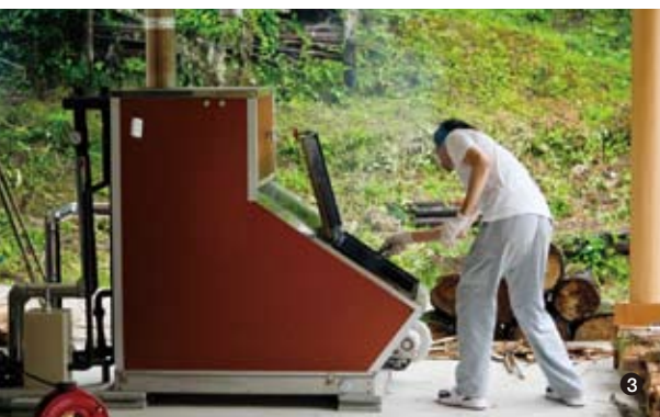
①「すげの里」全景。平成23年5月オープン ② 格子の裏面を使って情報共有 ③ 給湯と暖房をまかなう薪ボイラー
