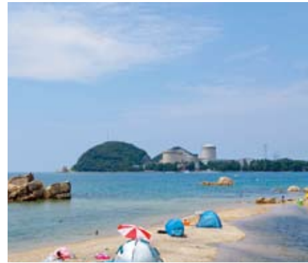
福井県美浜発電所
