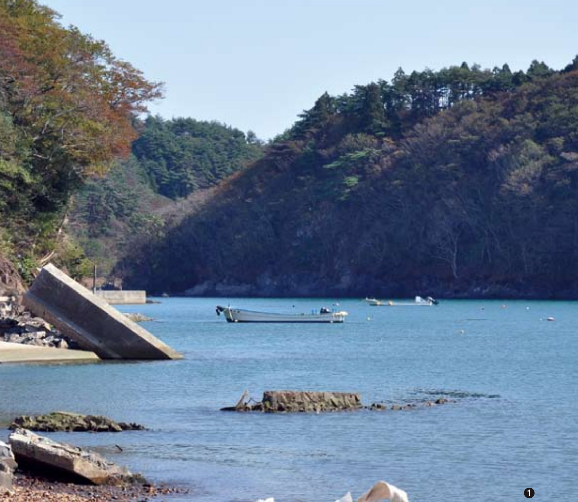
1 津波で防波堤も破壊された
