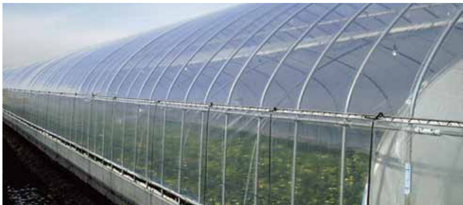
ハウスの外張りに使用される農POフィルム
