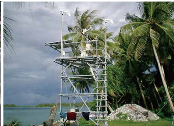
マーシャル諸島の小型風力発電と太陽光発電
