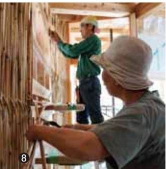
⑤地域の人、友人、大工さん、興味のある人が集った ⑥ヨシ葺き屋根葺留（よしとめ）四代目の竹田さんがヨシ関連の施工を担当 ⑦大岩先生⑧の指導で成安造形大学の学生もお手伝い ⑧壁の下地にヨシを縦横に組むヨシ小舞をしています
