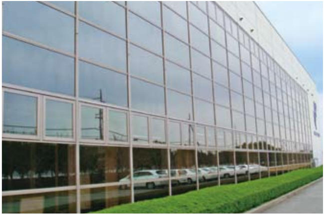
■遮熱フィルム 透明フィルムで明るさそのまま、紫外線カットにより空調効果を上げ、かつ飛散防止効果も実現します。
