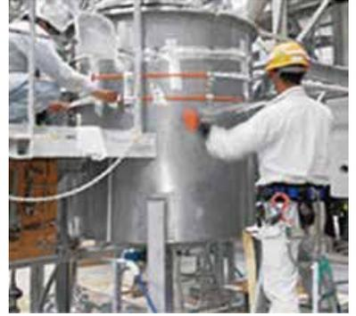
工場内の配管の保温、凍結防止のために採用された事例です。建物内だけでなく、屋外でも使用できます。配管の破裂や劣化などを防ぎ、製造効率を上げるためにも有効です。
