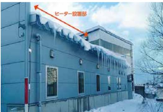
事務所や倉庫などで使用されることが多い折板屋根の氷柱防止に使用されました。折板屋根はその形状により氷柱が発生しやすく、氷柱の落下による危険や建物や屋根の変形などの被害をもたらしますが、その被害を防ぐために使用されています。
