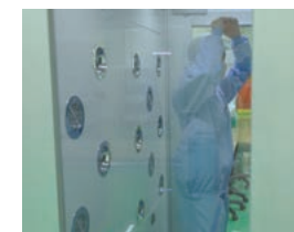
作業用エアシャワー
